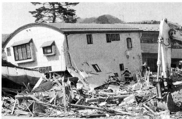
1階天井まで浸水して大きく傾いた岩手日報大船渡支局。解体後、流出した陸前高田支局と合同支局として盛町に再開。
